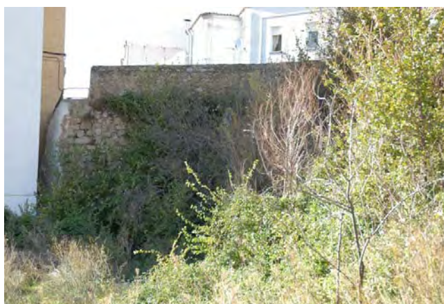
Tramo 8, en enlace con el segundo recinto.
