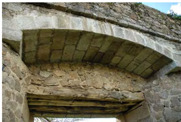
Tramo 19, Puerta Nueva del Pico, bóveda y dintel
