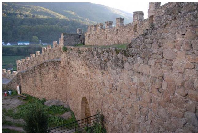
Tramos 21 y 22, intramuros, general
