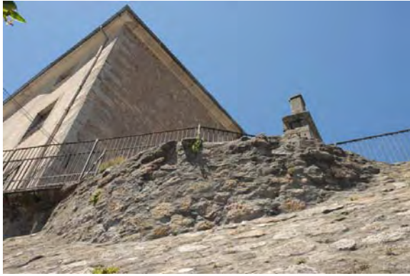
Tramo C5, detalle torreón integrado
