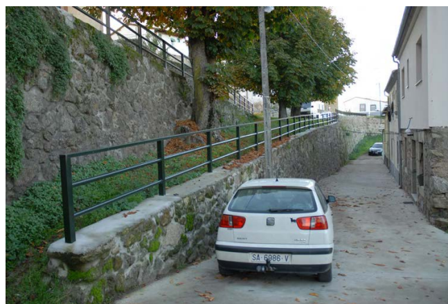
Tramo 31, extramuros, general desde final
