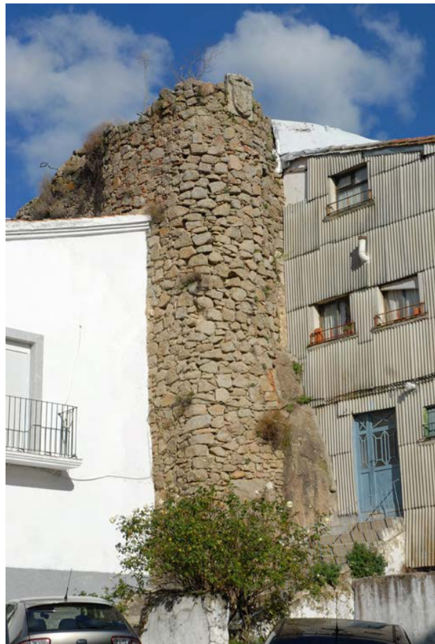
Tramo C1. Torreón, desarrollo de fábrica exterior
