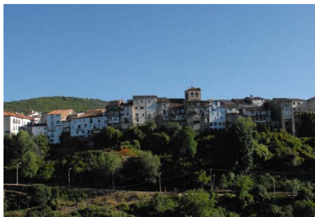
Tramo 41, extramuros, edificación superpuesta a la muralla
