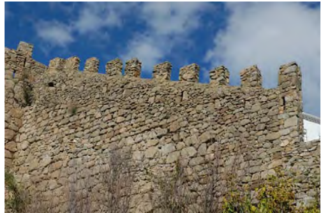
Tramo 21, extramuros, detalle coronación
