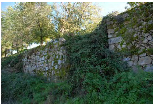
Tramo 29, extramuros, arranque posible restos de Puerta de Santa María
