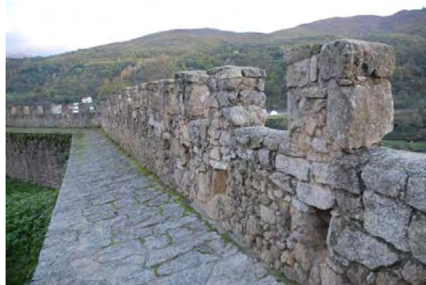
Tramos 19 y 20, intramuros, adarve
