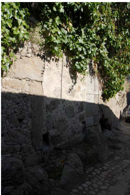
Tramo 2, puerta cegada
