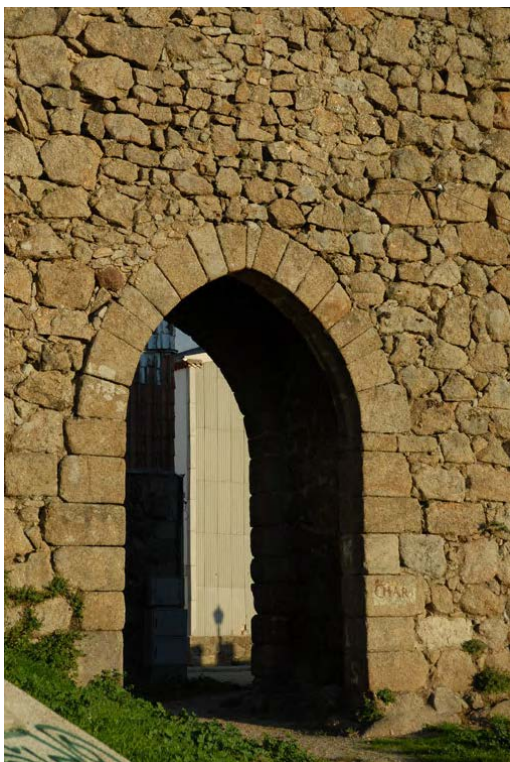
Tramo 22, extramuros, Puerta del Pico
