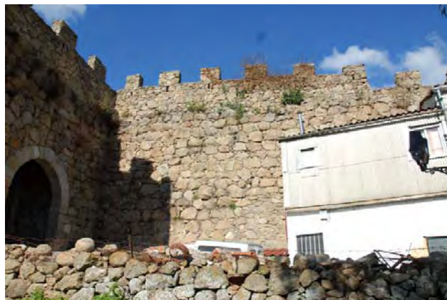
Tramo 14, extramuros, parcial en encuentro con Puerta de San Pedro
