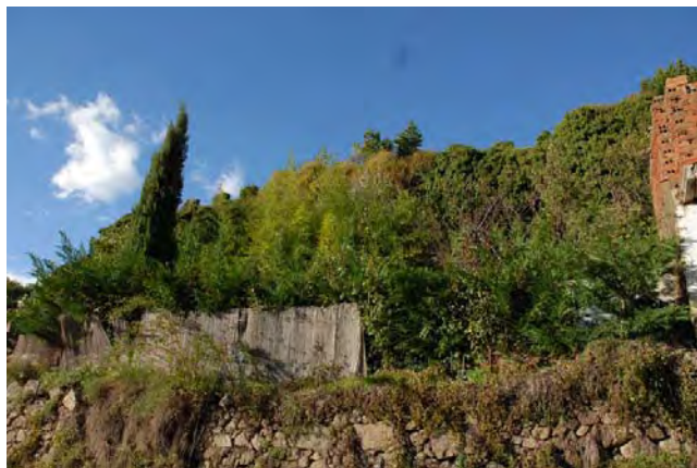
Tramo 13, extramuros, tramo intermedio
