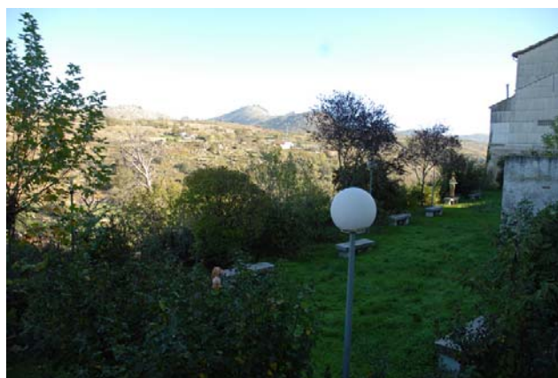
Tramo 48, intramuros, muro de jardín en coincidencia con recinto
