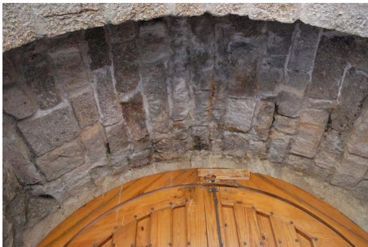
Tramo C2. Lienzo al Huerto del Aire, Puerta del Aire, bóveda reconstruida
