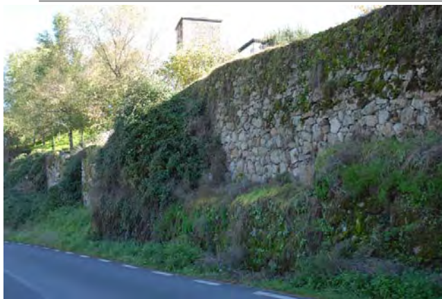
Tramo 28, extramuros, zona final, zócalo resaltado
