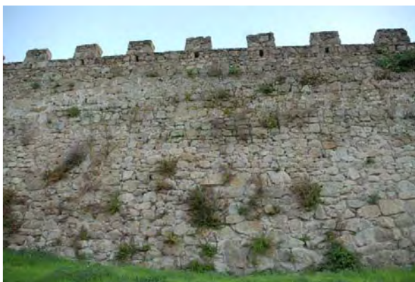
Tramo 25, extramuros, desarrollo 3
