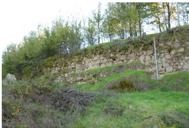
Tramo 29, extramuros, zona final
