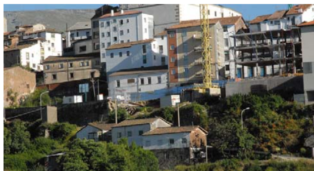
Tramos 43 y 44, extramuros, solar en construcción, con restos de la Puerta Nueva
