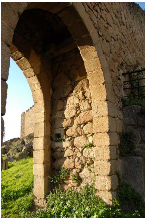
Tramo 22, Puerta del Pico, lateral derecho
