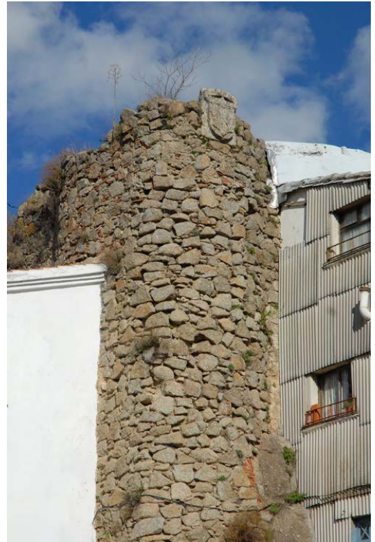
Tramo C1. Torreón, detalle coronación exterior
