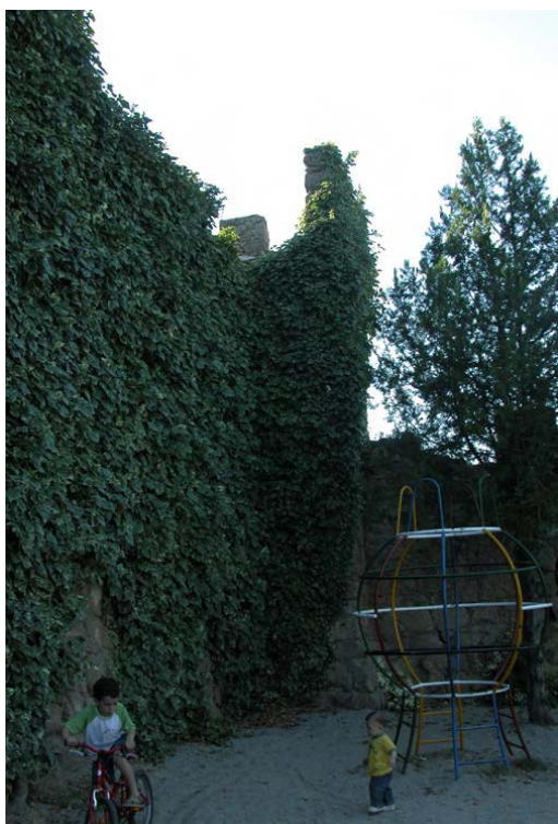
Tramo 24, intramuros, detalle torre esquina
