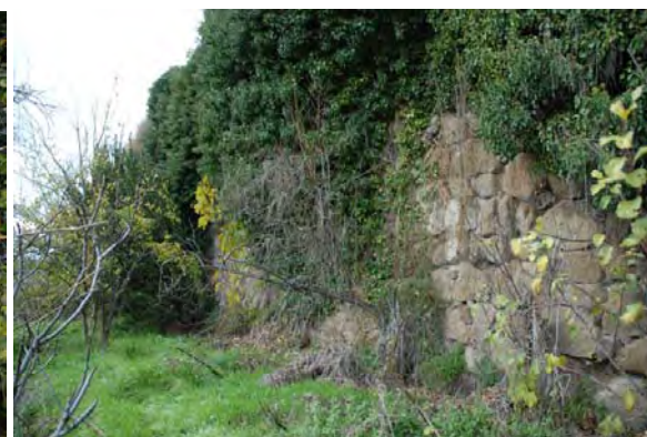
Tramo 13, extramuros, detalle arranque
