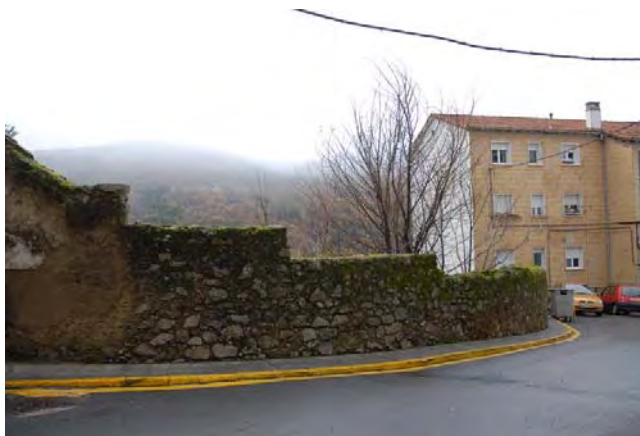
Tramo 8, tapia sobre la muralla
