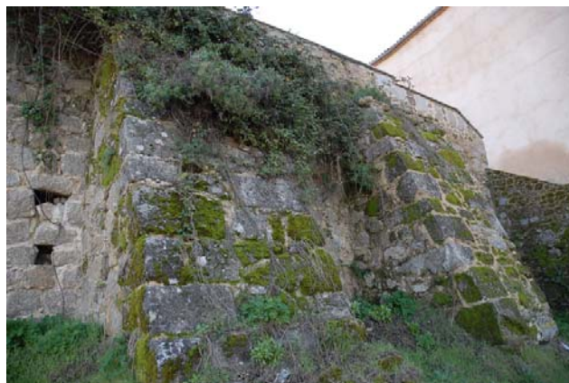
Tramo 46, extramuros, lateral oeste general, detalle muro
