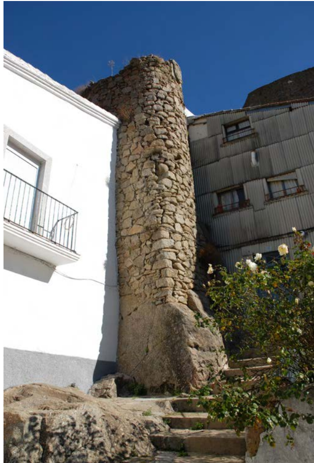
Tramo C1. Torreón a la Plaza de San Juan Bautista
