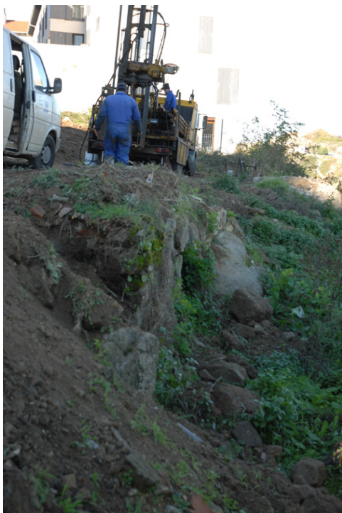
Tramo 43, solar en construcción, con restos, junto a Puerta Nueva
