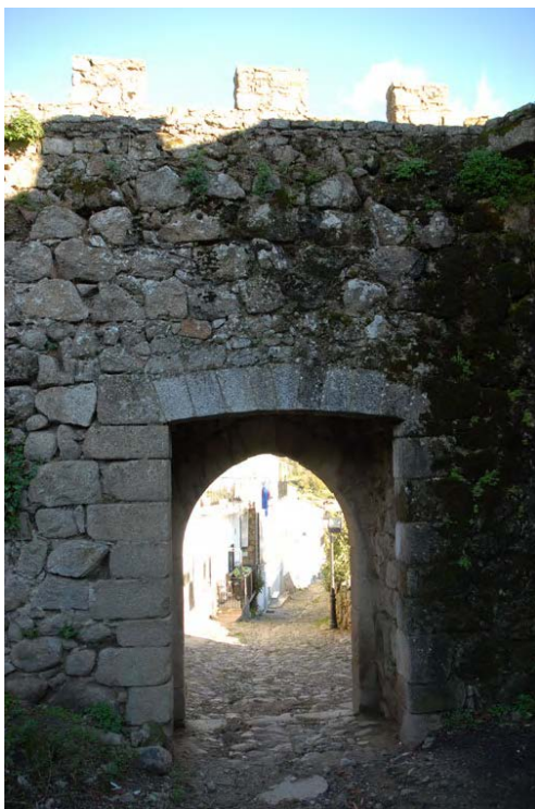
Tramo 15, intramuros, Puerta de San Pedro
