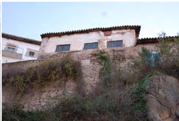
Tramos 36, extramuros, detalle paramento
