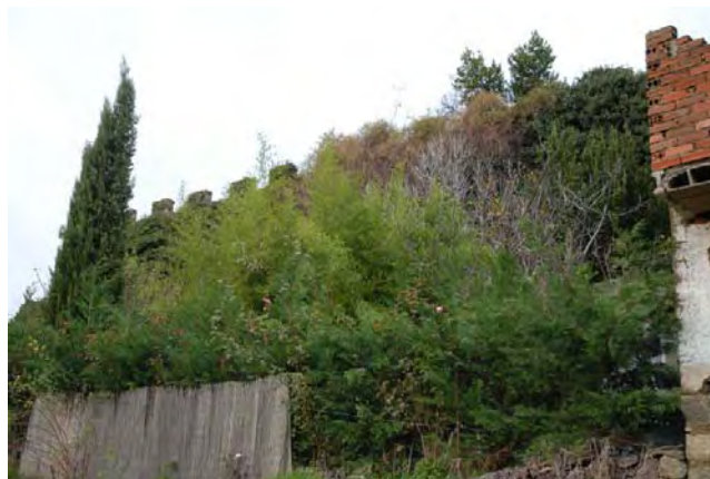
Tramo 13, extramuros, detalle coronación tramo intermedio
