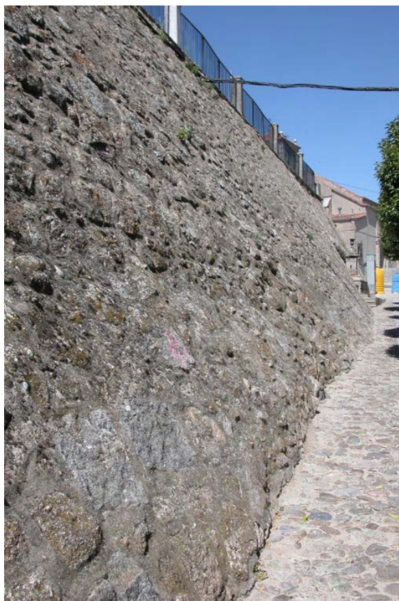
Tramo C5, detalle desde el oeste
