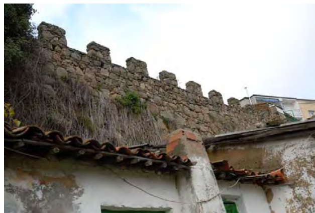
Tramo 12, extramuros, detalle lienzo, sobre edificaciones adosadas
