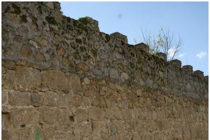
Tramo 18, intramuros, zona intermedia, detalle rejuntado cemento
