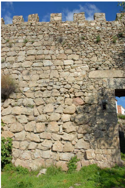
Tramo 19, extramuros, detalle paño lateral de la puerta
