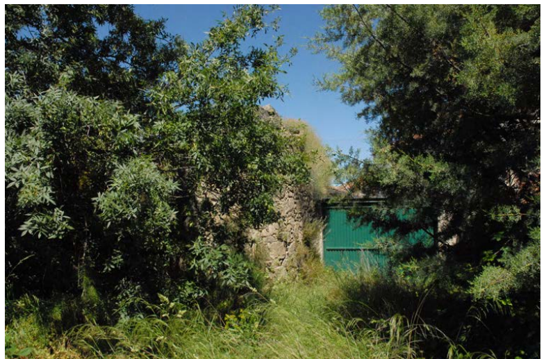
Tramo C1. Extramuros, fachada al patio oeste del palacio
