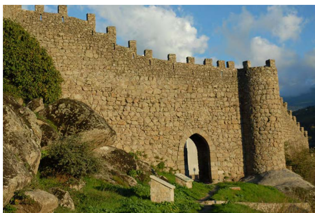
Tramo 22, extramuros, tramo puerta y torreón
