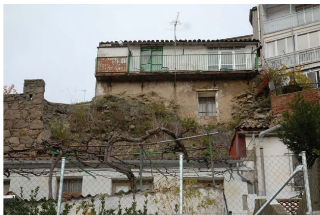
Tramo 11, lienzo sin restaurar
