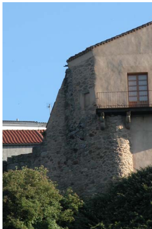
Tramo 46, extramuros, torreón incorporado a la fachada norte
