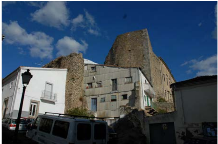
Tramo C1. Extramuros desde la Plaza de San Juan Bautista
