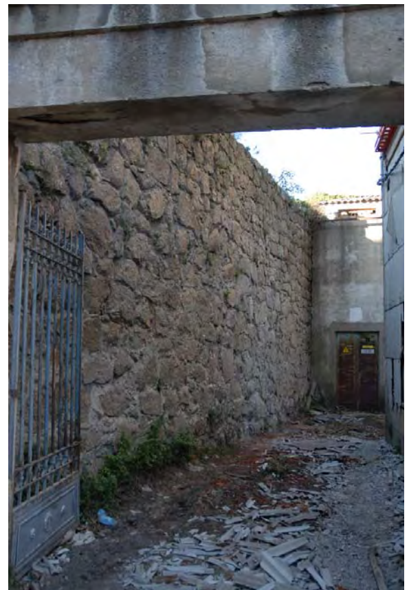
Tramo C2. Lienzo a la Plaza Mayor, extremo norte
