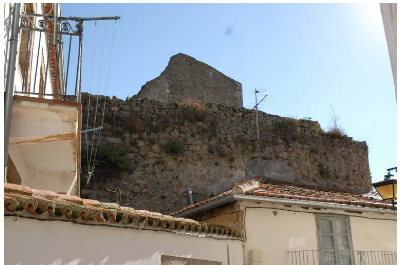
Tramo C1. Extramuros, coronación sobre edificaciones adosadas
