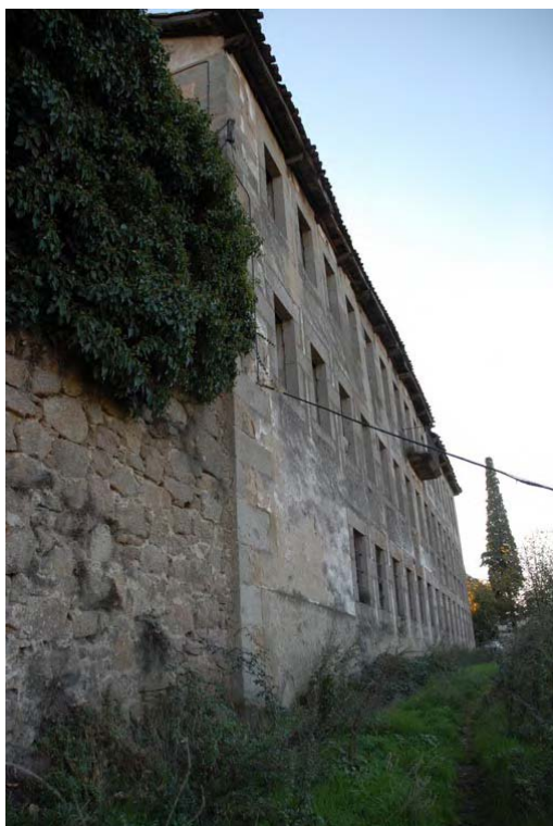
Tramo 33, extramuros, nave superpuesta con recinto amurallado
