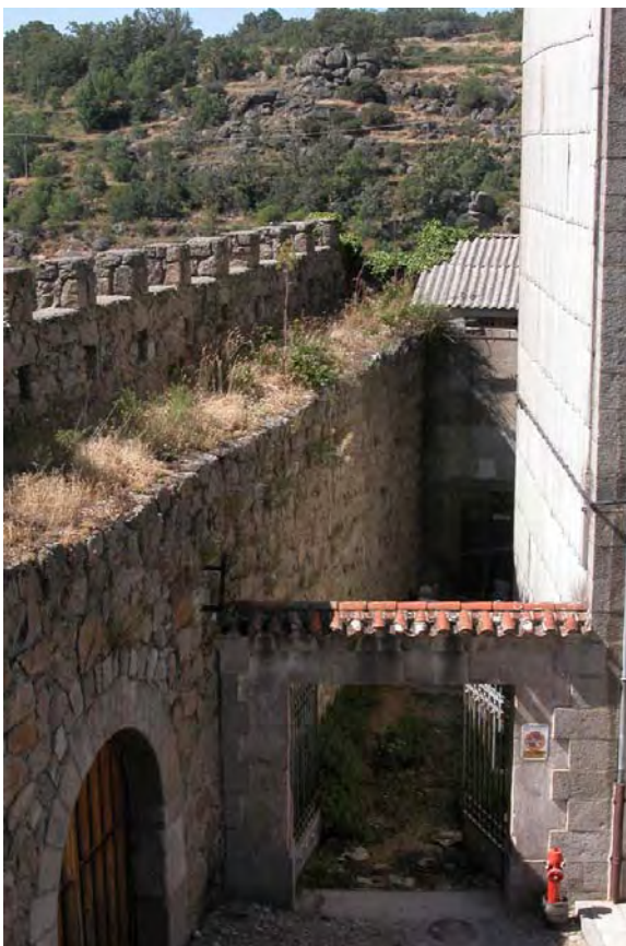
Tramo C2. Lienzo a la Plaza Mayor, adarve extremo norte
