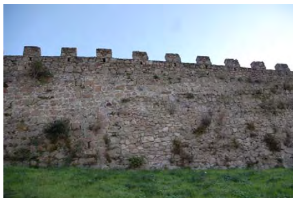
Tramo 25, extramuros, desarrollo 4
