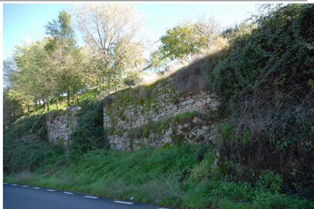
Tramo 28, extramuros, zona final, posibles restos de Puerta de Santa María
