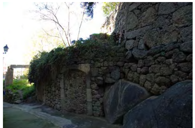
Tramo 4, detalle quiebro y portilla cegada
