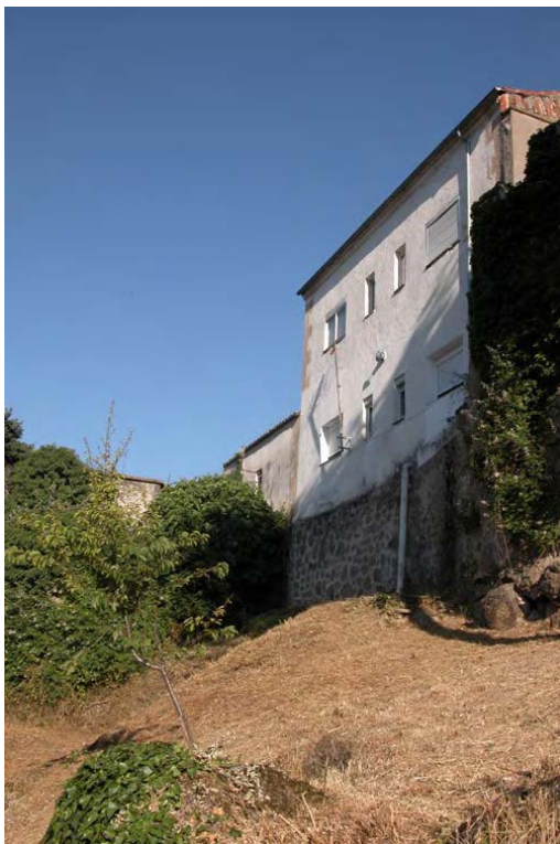
Tramo 27, extramuros general, edificación superpuesta
