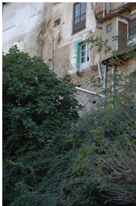
Tramo 41, extramuros, Puerta Ciega, edificación superpuesta a la muralla
