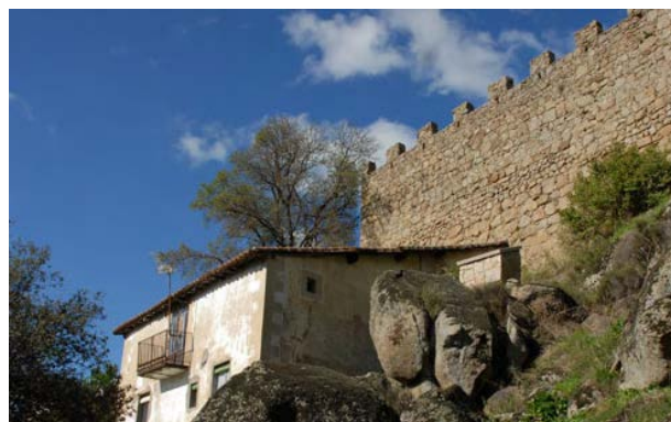
Tramo 19, extramuros lado sur
