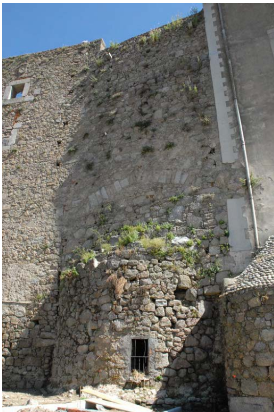
Tramos recinto exterior del castillo, lado sur con torreón
