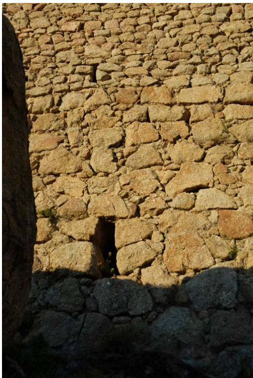
Tramo 23, extramuros, final detalle con desagüe
