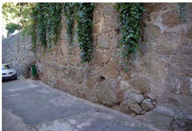
Tramo 3, detalle basamento
