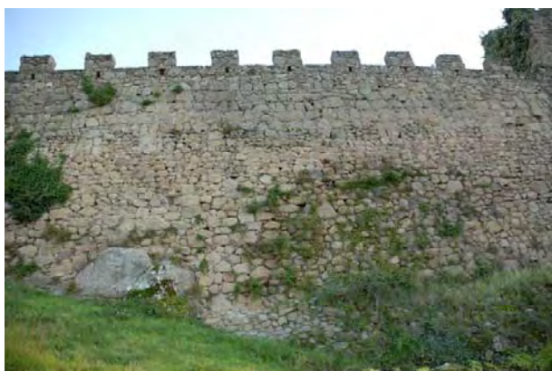
Tramo 25, extramuros, desarrollo 1
