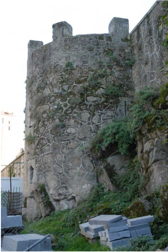
Tramo C3, torreón desde el oeste
