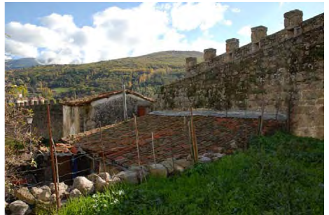
Tramo 17, intramuros vista general desde el oeste
