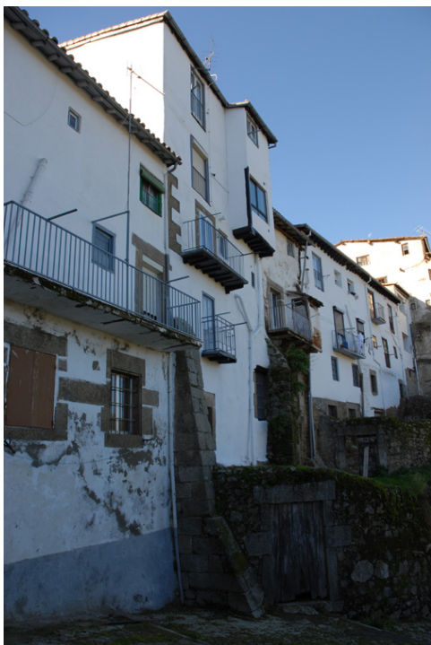
Tramo 41, extramuros, zona final, edificación superpuesta a la muralla
