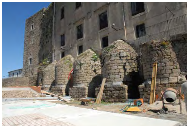
Tramos recinto exterior del castillo, lado sur
