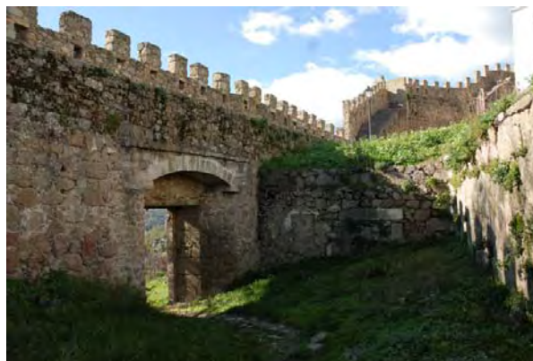
Tramo 19, intramuros, puerta y fielato
