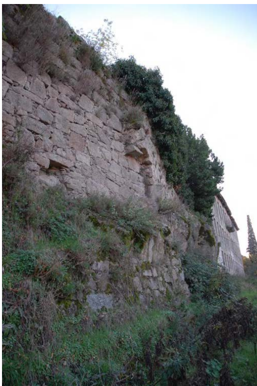
Tramo 34, extramuros, lienzo norte
