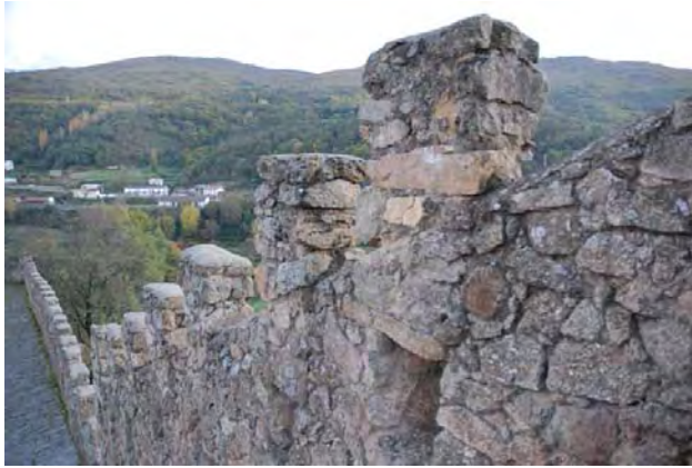
Tramo 21, intramuros, detalle coronación
