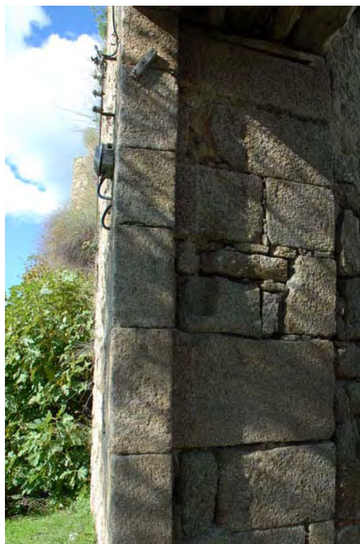
Tramo 19, Puerta Nueva del Pico, lateral derecho
