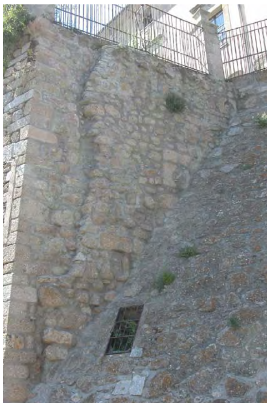
Tramo C5, esquina con troneras cegadas
