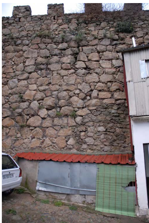
Tramo 14, extramuros detalle paramento
