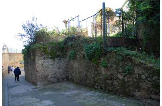
Tramo 1, arranque con rampa de acceso a la parcela
