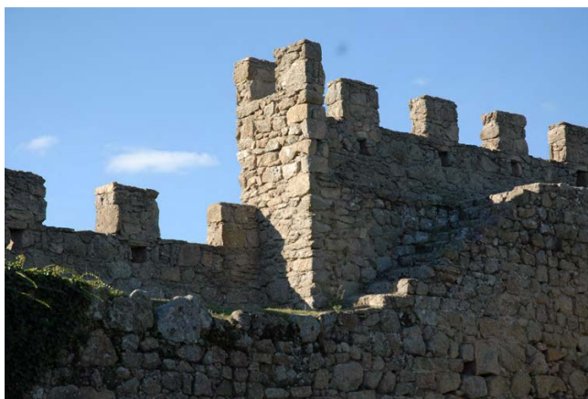
Tramo 24, intramuros, detalle coronación zona intermedia
