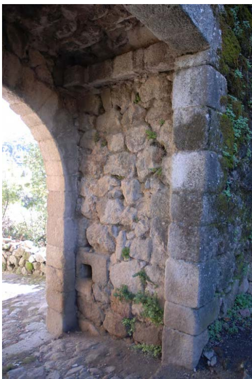
Tramo 15, lateral interior derecho de la puerta de San Pedro
