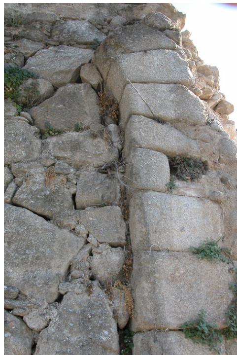
Tramo 44, extramuros, detalle de jamba de la Puerta Nueva
