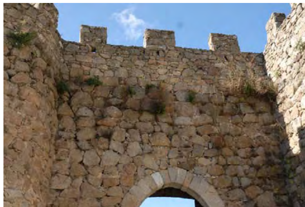
Tramo 15, extramuros, detalle fábrica coronación
