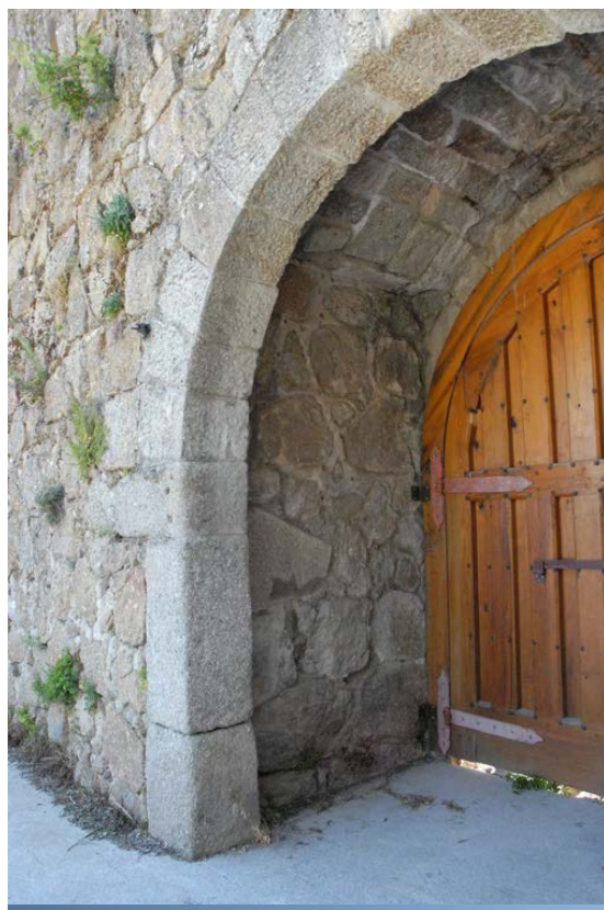
Tramo C2. Lienzo al Huerto del Aire, Puerta del Aire, detalle arranque de jamba original
