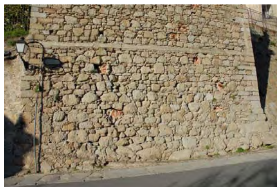
Tramo C6, cuerpo elevado, detalle parte baja
