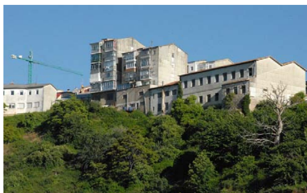
Tramo 49, extramuros, lienzo desaparecido o bajo la edificación
