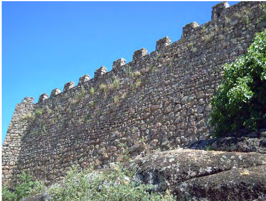
Lienzo sur junto a la Puerta del Pico. Distintas fases constructivas
