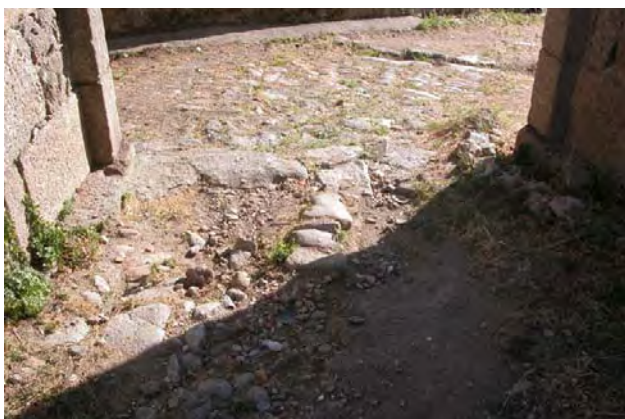
Tramo 19, Puerta Nueva del Pico, restos de solado
