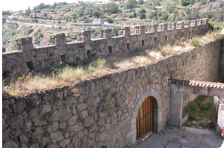
Tramo C2. Lienzo a la Plaza Mayor, adarve
