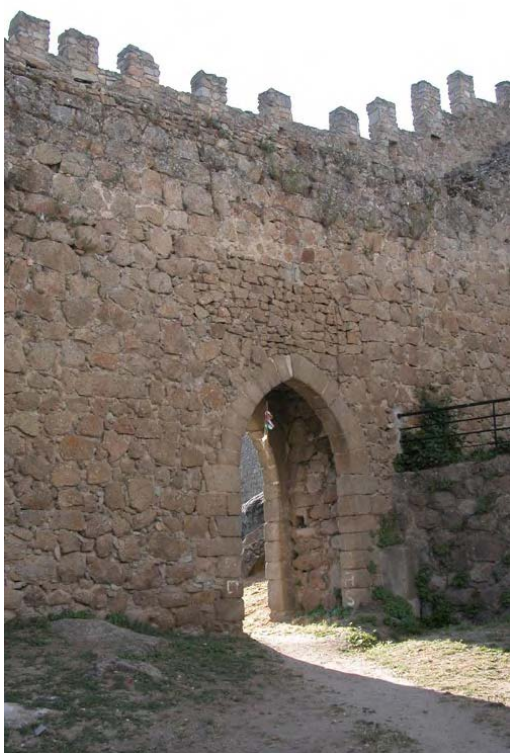
Tramo 22, intramuros, Puerta del Pico
