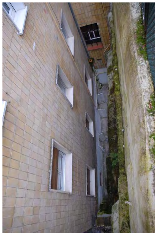
Tramo 9, posible restos de muralla en límite de patio inglés de bloques y Calle Padre Roca
