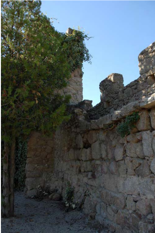
Tramo 25, intramuros, arranque torre esquina
