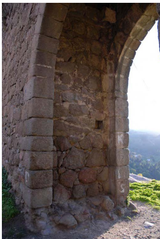
Tramo 22, Puerta del Pico, lateral izquierdo
