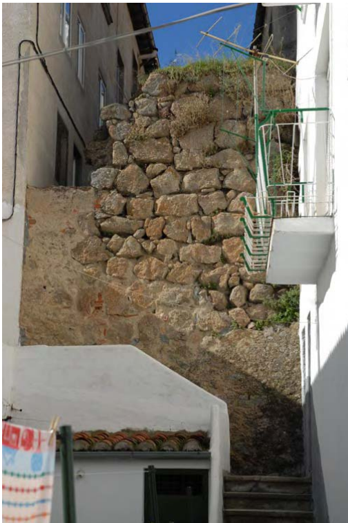
Tramo 10, lienzo entre edificaciones, Travesía de Padre Roca
