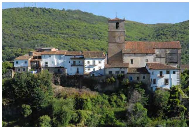
Tramos 35 a 37, extramuros edificaciones superpuestas
