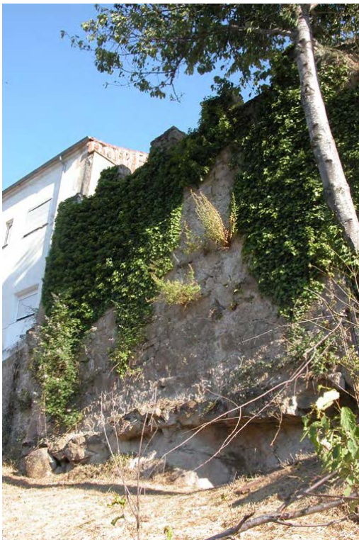
Tramo 26, extramuros, detalle zona final
