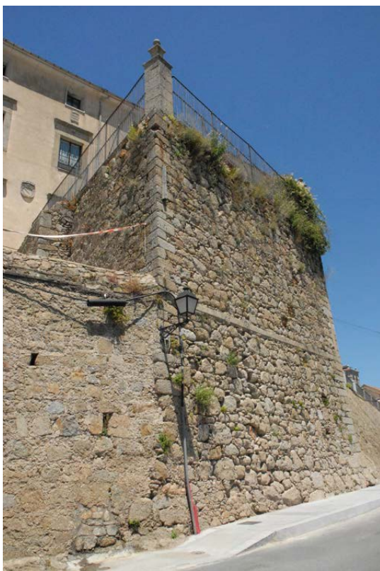
Tramo C6, cuerpo elevado en encuentro con la Puerta de los Osos
