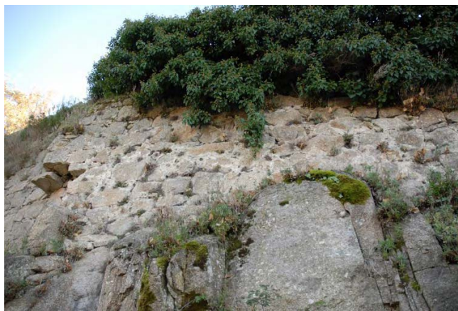
Tramo 34, extramuros, detalle muro sobre roca
