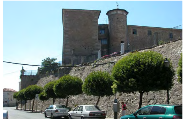
Tramo C5, Vista general desde el este
