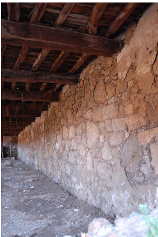
Tramo 33, extramuros. Interior nave superpuesta con recinto, posible muro coincidente
