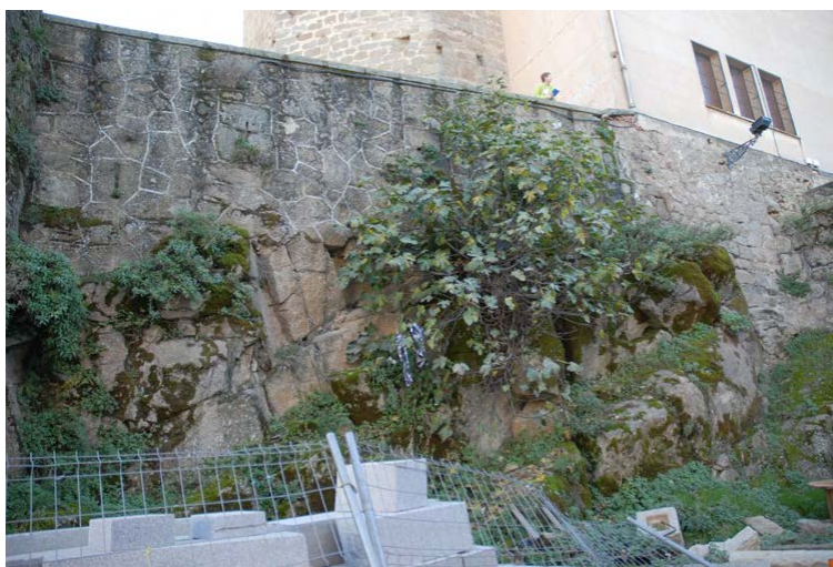
Tramo C3, contacto con tramo C2
