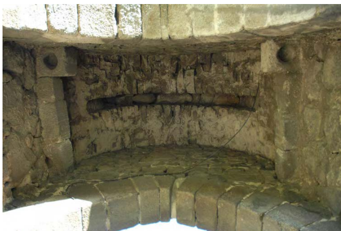
Tramo 22, Puerta del Pico, bóveda
