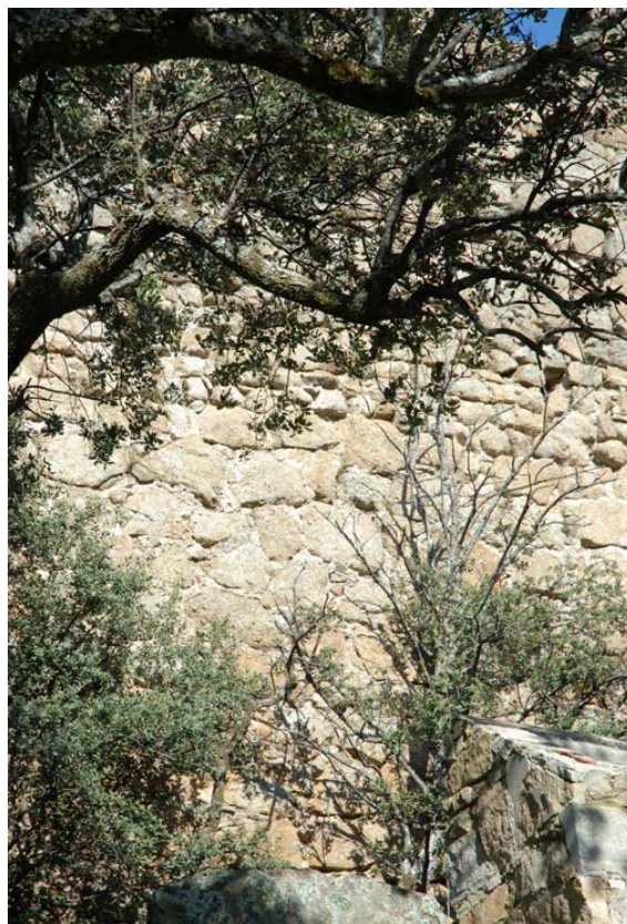
Tramo 16, extramuros, zona final, detalle fábrica
