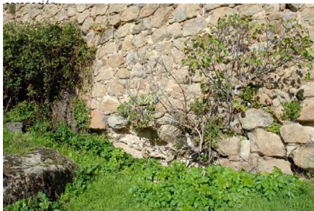
Tramo 18, extramuros, detalle fábrica arranque
