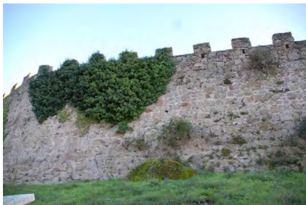
Tramo 25, extramuros, desarrollo 5
