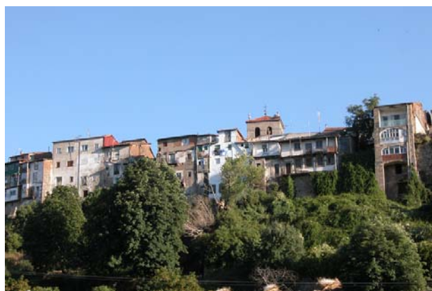
Tramo 41, extramuros, arranque, edificación superpuesta a la muralla
