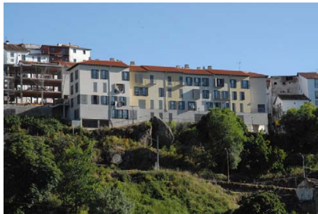
Tramo 42, extramuros, muralla desaparecida bajo bloque de viviendas
