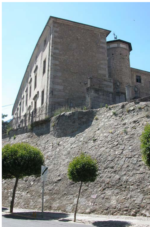
Tramo C5, con torreón integrado
