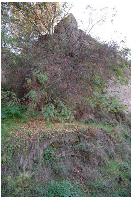
Tramo 34, extramuros, esquina
