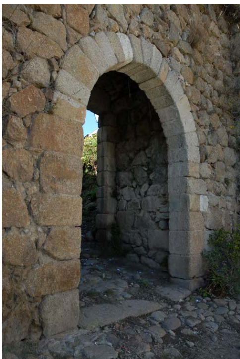
Tramo 15, extramuros, Puerta de San Pedro
