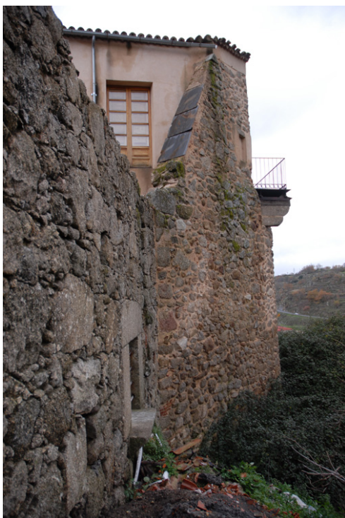
Tramos 46 y 47, extramuros, parcial con torreón incorporado a la fachada
