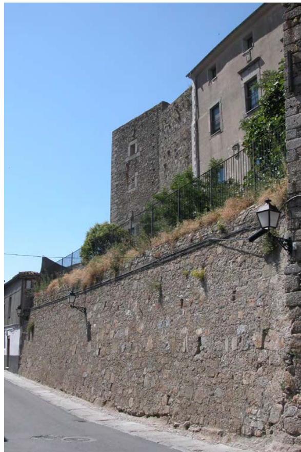
Tramo C6, muro de contención del jardín meridional del palacio
