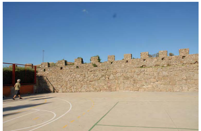
Tramo 26, intramuros, parcial desde final
