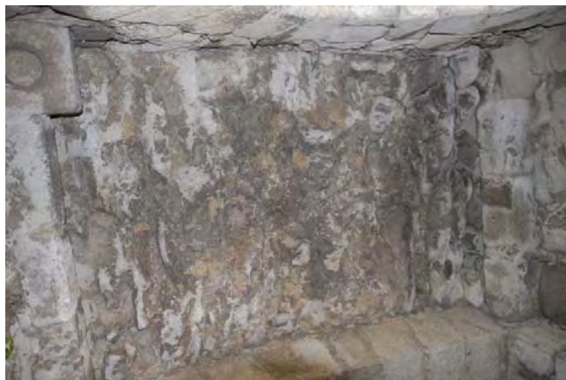
Tramo 15, bóveda de la puerta de San Pedro
