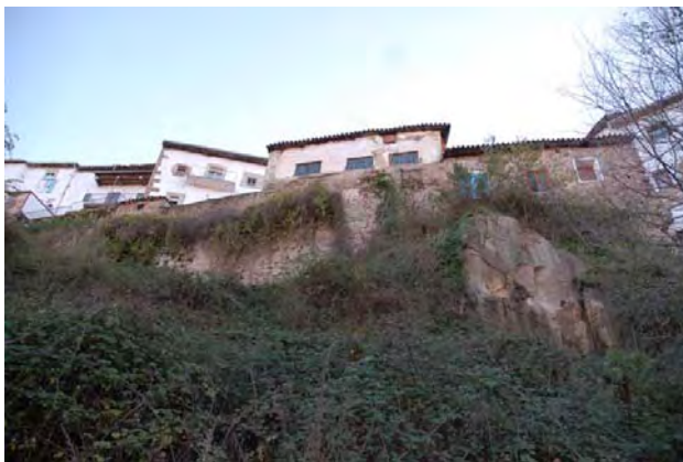
Tramos 36 y 37, extramuros, edificaciones superpuestas
