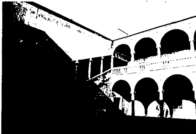
①. VISTA INTERIOR. PATIO.
