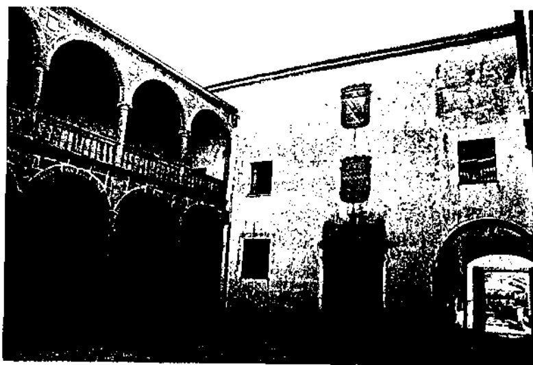
②. VISTA DEL PATIO INTERIOR. ACCESO.
